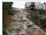
Prédio condenado desaba emBH
